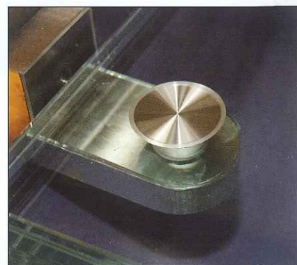
Point de fixation fraisé et noyé dans la masse
